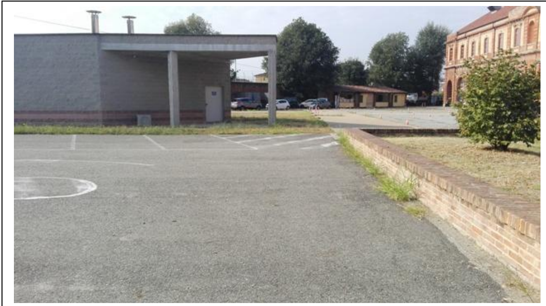
FOTO N°11 – area est – palazzina impianti edificio scolastico esistente – vista area da recintare
