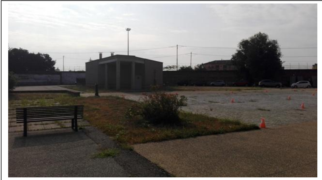
FOTO N°5 – area est – palazzina impianti edificio scolastico esistente – vista area da recintare
