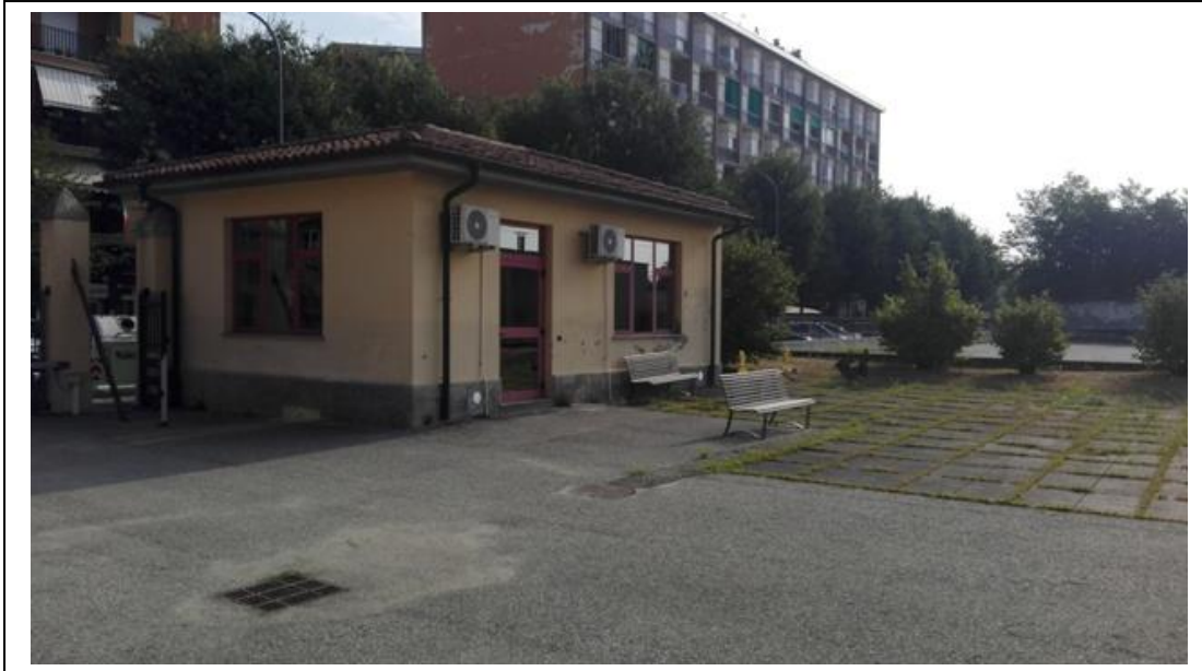
FOTO N°3 – area ovest – palazzina deposito ASP Servizi – estremità ovest area da recintare
