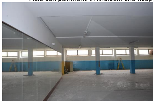
Locali piano interrato con pavimenti in linoleum che ricoprono i vecchi pavimenti in MCA che andranno bonificati
