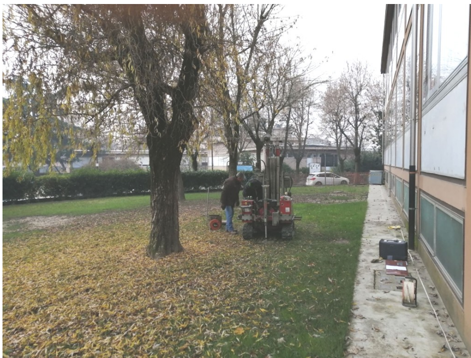
Foto 3.1 – Strumentazione utilizzata per l'esecuzione delle prove penetrometriche statiche: penetrometro superpesante Pagani TG 63/200 in corrispondenza della verticale C.P.T. 1.
